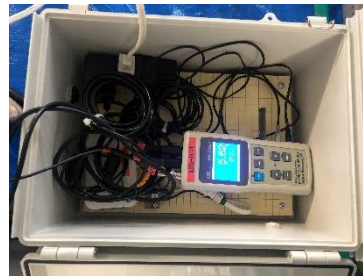
防水 BoX 内部の水質計等
